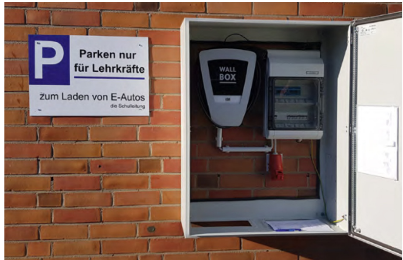
Beitrag zur CO 2 -Reduzierung: Aufstellen von E-Ladesäulen auf dem Lehrkräfteparkplatz.
